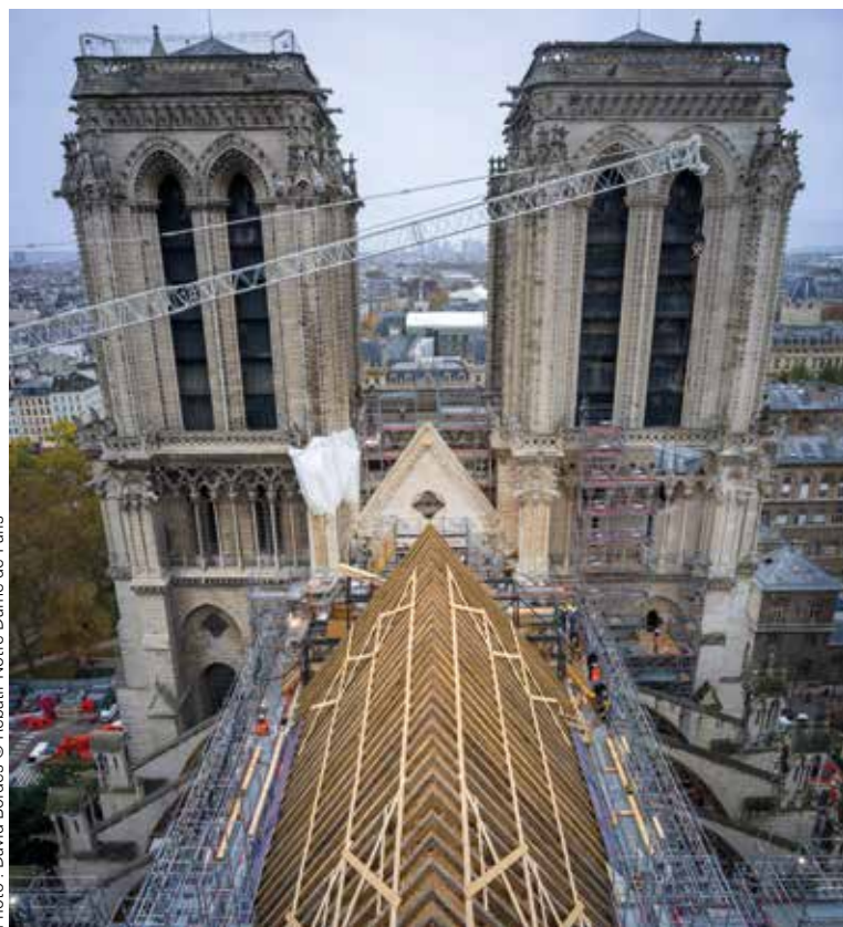
Charpente de la nef pendant le chantier de restauration.
