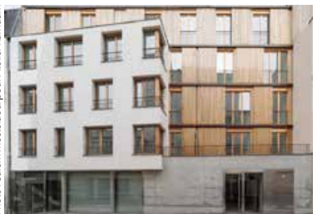
Photo : Salem Mostefaioui pour Atelier Ramdam
