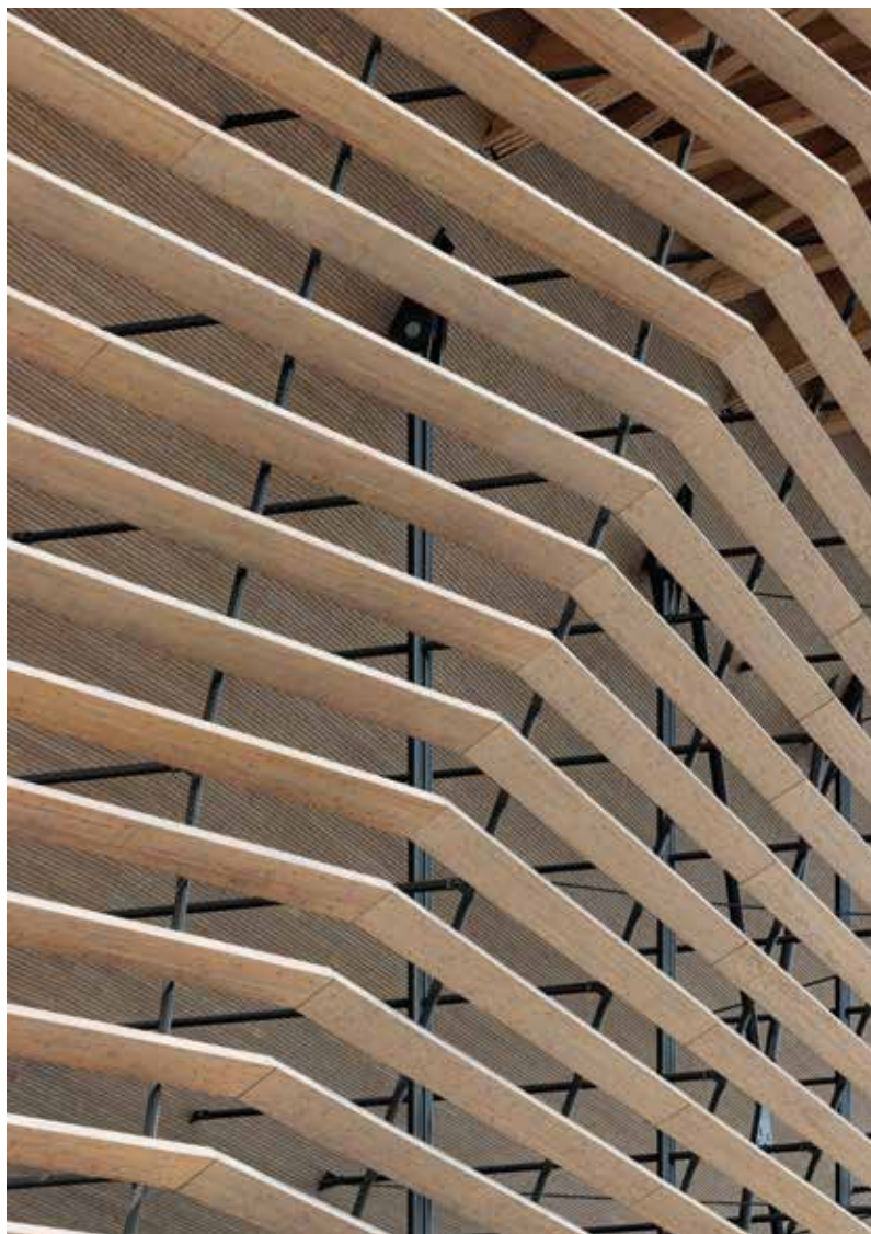
▲ Gros plan sur les brise-soleil en bois contribuant au confort thermique du centre aquatique de Saint-Denis. Architectes : Ateliers 2/3/4 et VenhoevenCS.
