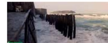
« À Saint-Malo, les brise-lames réalisés avec des poteaux en bois permettent d'atténuer la force de la vague sur la digue et la protéger. Si la digue se fragilise puis s'effondre, on se retrouve avec des inondations et une population en danger. » DDTM, Sandrine Mary
