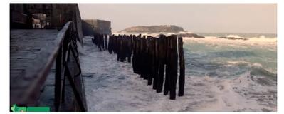
« À Saint-Malo, les brise-lames réalisés avec des poteaux en bois permettent d'atténuer la force de la vague sur la digue et la protéger. Si la digue se fragilise puis s'effondre, on se retrouve avec des inondations et une population en danger. »
