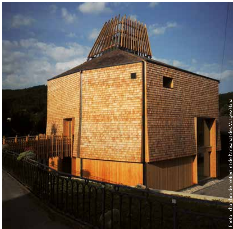
▲ Le projet Périscolaire Tendon (88) valorise les savoir-faire de la filière forêt-bois de proximité, de la scierie à la construction. Panneaux à caissons en hêtre (murs et toiture), planches d'épicéa sur chant clouées (plancher), hêtre massif (revêtement mural, plafond, escalier, portes), tavaillons de mélèze (bardage). Maître d'ouvrage : Commune de Tendon (88) ; maître d'œuvre : Claude Valentin, Haha Atelier d'Architecture (88). Opération pionnière initiée avec la chambre de métiers et de l'artisanat des Vosges et le Critt Bois. Premier Prix national de la construction bois 2012.
