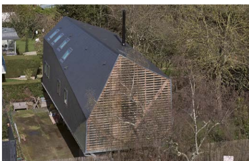
◀ Couverture et façades sont recouvertes d'ardoise naturelle à l'exception des façades côté rue, habillées de carreaux de verre.
