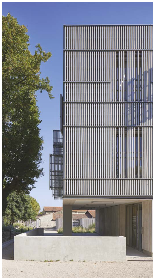
▲ Du pin d'Alep issu de la forêt des Alpilles pour le bardage, les brise-soleil et les volets.
