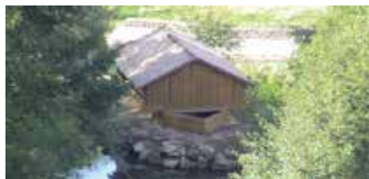
Bateau-lavoir à Semur-en-Auxois, Côte-d'Or (21) - Restauration de la toiture Ce bateau-lavoir est l'un des derniers en Bourgogne et une richesse culturelle qui entretient la mémoire collective. Sa toiture fortement dégradée sera refaite à l'identique avec des bardeaux en châtaignier fendu de type monuments historiques de 100 à 120 m 2 sur liteaux de 27 x 40 en sapin traité.
