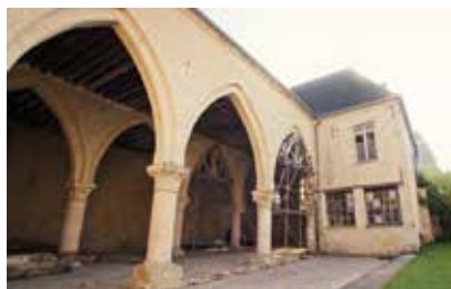
Hôtel-Dieu de Galande (13 e siècle), à Senlis, Oise (60) Reprise de la charpente historique dans le cadre de la réhabilitation et de l'aménagement de la grande salle médiévale. Essence : chêne
