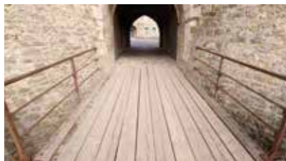
Château d'Aumont (13 e siècle), à Boulogne-sur-Mer, Pas-de-Calais (62) Remise à neuf du pont-levis construit au 13 e siècle. Essences : chêne et azobé
