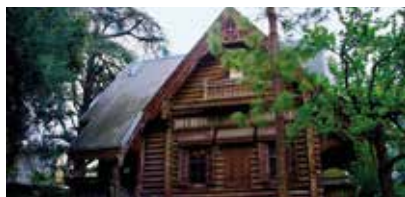
Isba du domaine de Valrose, Nice, Alpes-Maritimes (06) - Restauration de l'ensemble Cette isba exceptionnelle en France, constituée de rondins de sapins assemblés à mi-bois et en bois ouvré et d'un plancher en bois sur poutres, retrouvera son éclat d'origine. Essence : choix soumis aux prescriptions de la Drac, aux préconisations de l'architecte en chef des monuments historiques.
