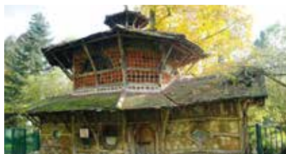
Fabriques du Jardin botanique de Tours, Indre-et-Loire (37) - Restauration de la charpente La Fabrique des Wallabies a besoin d'une rénovation structurelle : poutres brutes d'ornementation et charpente à reprendre entièrement. Une vigilance particulière sera apportée au choix des essences et à leur origine géographique au moment de la rédaction du cahier des charges.
