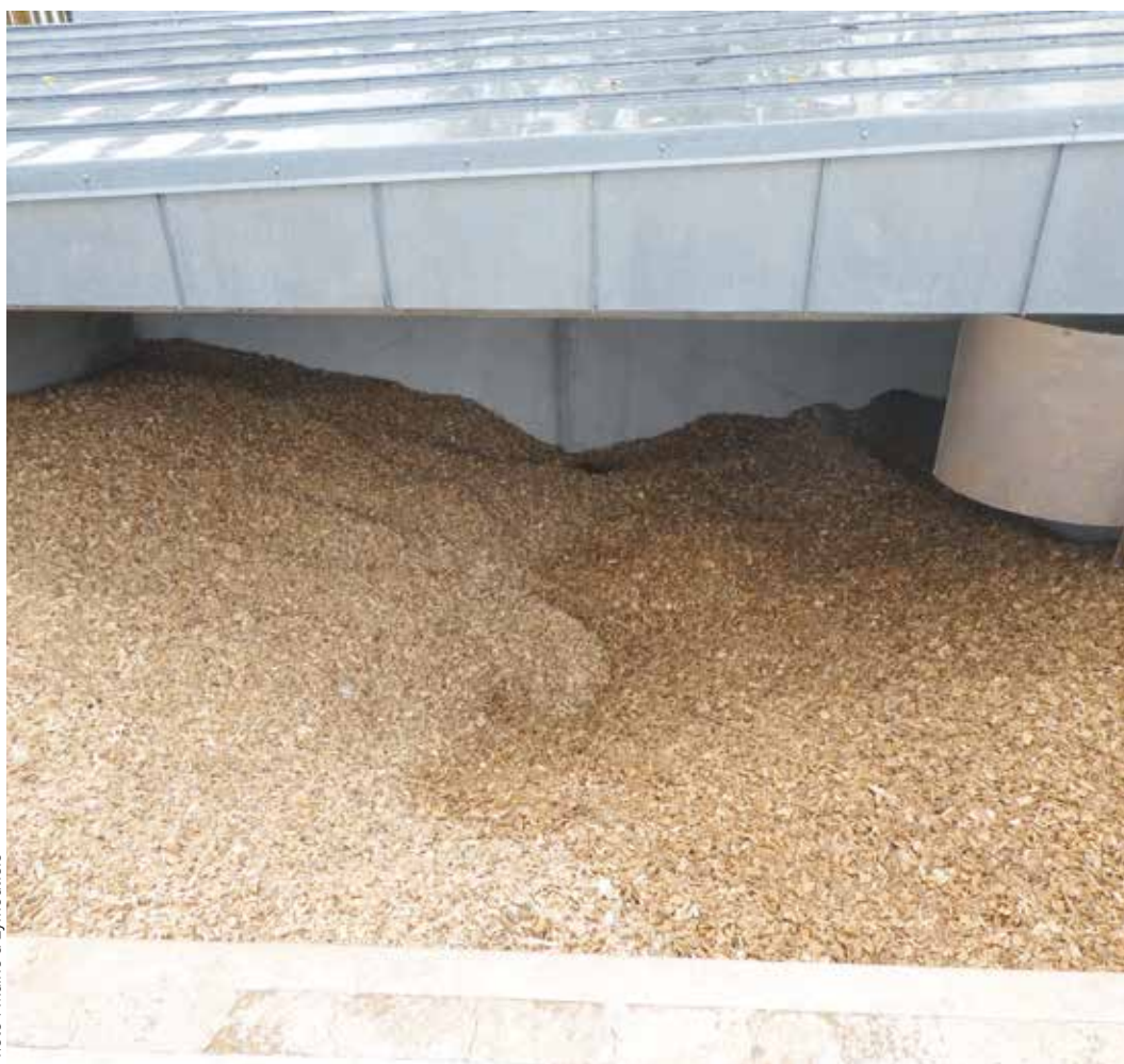
◀ Silo de stockage de plaquettes forestières au pied d'un bâtiment de logements d'Eymoutiers, chauffé au bois.
