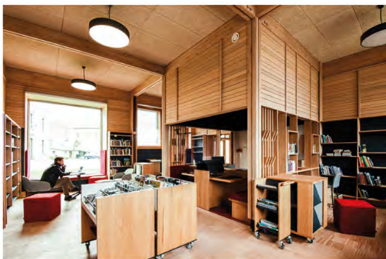
L'un des plus anciens bâtiments de la commune d'Arches (88) a fait l'objet d'une réhabilitation en vue de sa transformation en pôle socio-culturel baptisé « L'Hétraie ». Essences : hêtre (structure et menuiseries) ; Douglas (entrants et chevrons), poutres en épicea (caissons de toiture). Architecte : Haha Atelier d'Architecture. Photo : Matthieu Claudel
