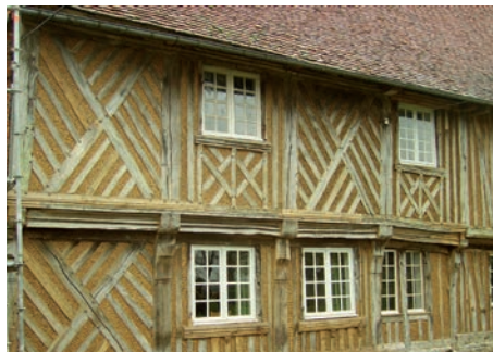
Manoir d'Hautel-Mesnil à Montreuil-en-Caux, en Seine-Maritime : pan de bois XVI e siècle en encorbellement.
