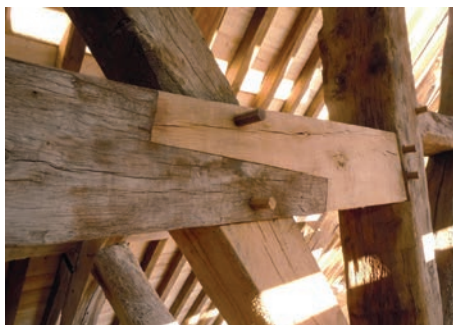
Assemblage à trait de Jupiter, gros plan.
