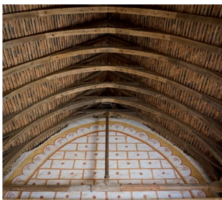
Charpente à chevron formant ferme du logis du château.
