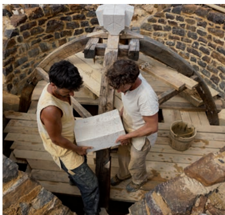
Installation d'un cintre pour poser les voussoirs des nervures d'une voûte.
