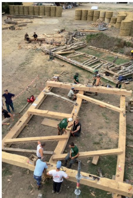
Mise sur épure d'un pignon en pan de bois trop dégradé pour être restauré. Les rares pièces de bois pouvant être sauvées sont placées parmi les bois neufs dans leur position d'origine.
