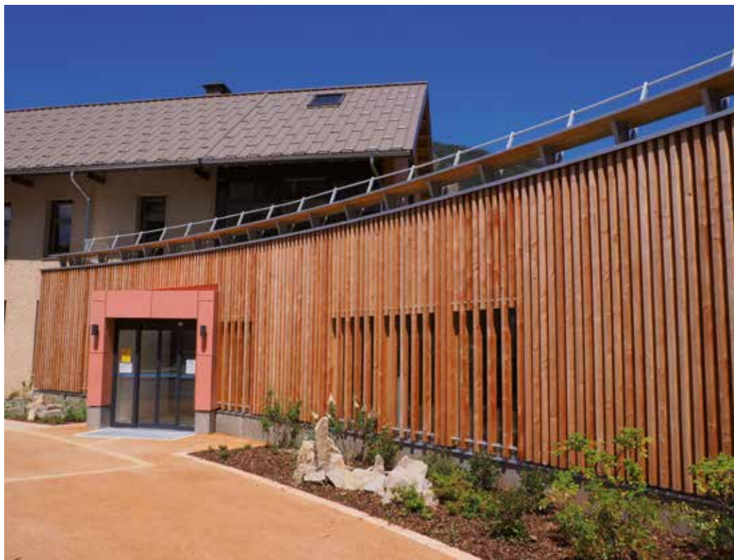
◀▼ La façade est rythmée par un bardage de carrelots de mélèze ajourés qui participe à l'intégration de l'extension à l'environnement.
