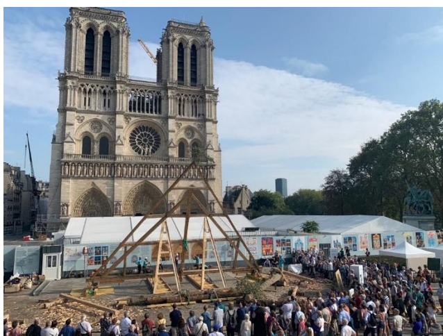
Visuel 1 – Journées européennes du patrimoine 2020 - Démonstration de levage de charpente depuis le parvis de la cathédrale Notre-Dame de Paris © Jérémie Patrier-Leitus / Etablissement public chargé de la conservation et de la restauration de la cathédrale Notre-Dame de Paris
