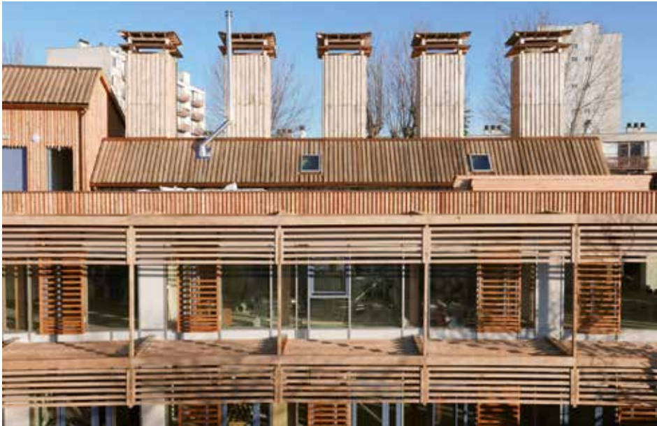
◀ Centre de loisirs Jacques-Chirac à Rosny-sous-Bois : murs en paille porteuse, charpente et membrures du bâtiment principal en peuplier d'Île-de-France et sapin des Vosges.
