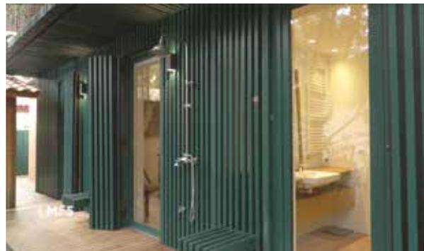
Elle a été réalisée en ossature bois en Pin des Landes pour un chantier propre et rapide, et avec un bardage en Douglas (Limousin).
