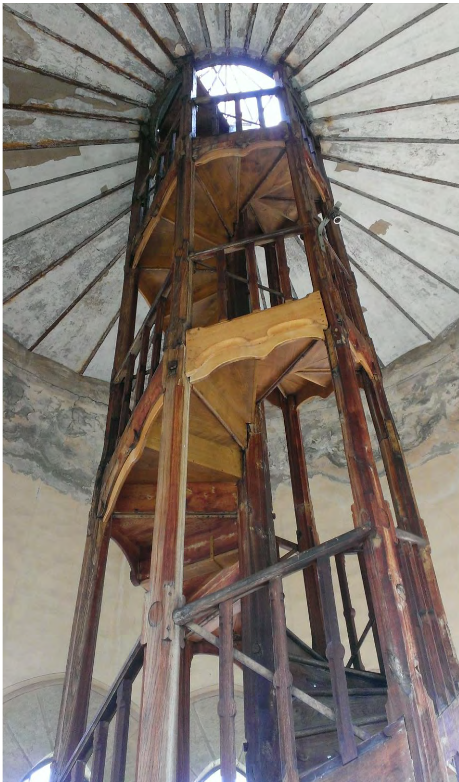
Limons et marches en hêtre qu'il convient de remplacer en chêne
