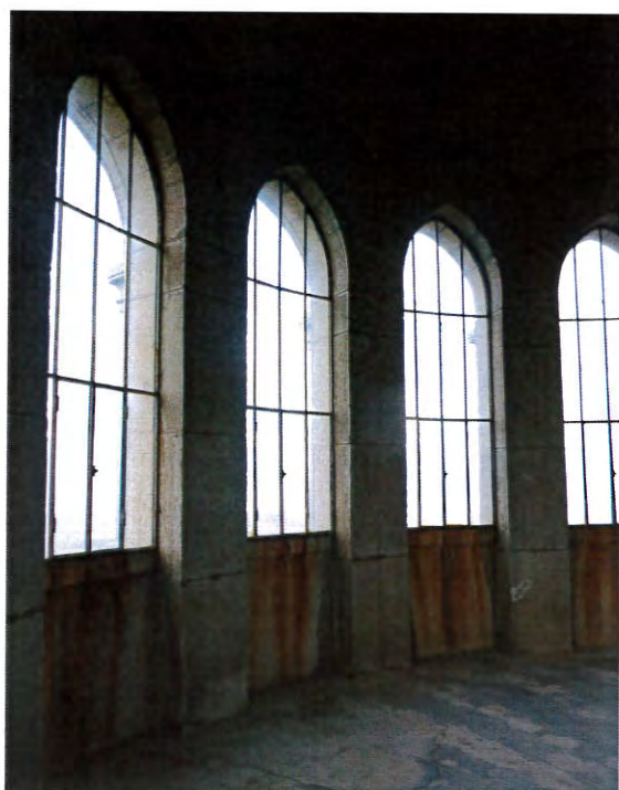
Baies en ogive du quatrième niveau fermées par des menuiseries métalliques - coulures de rouille - 2015
