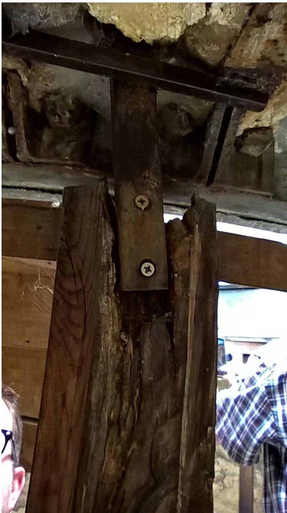
Le bois est désagréé autour des points de fixation
