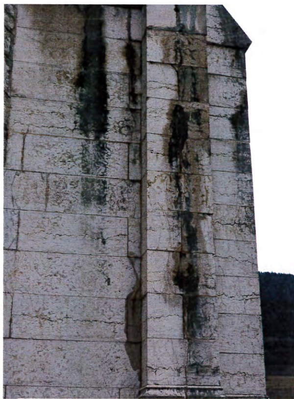
Porche d'entrée de la chapelle Infiltrations, développement de mousses, algues Fissures et joints dégradés - 2018
