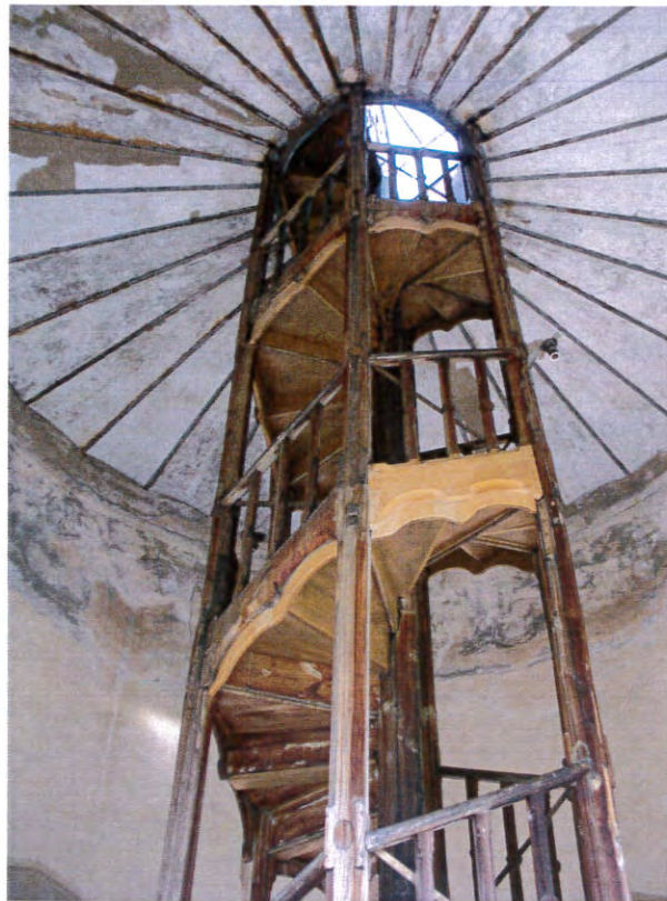
Partie haute de l'escalier hélicoïdal – décor de festons des chants des limons – réparations effectuées avec une essence de bois différente - 2018
