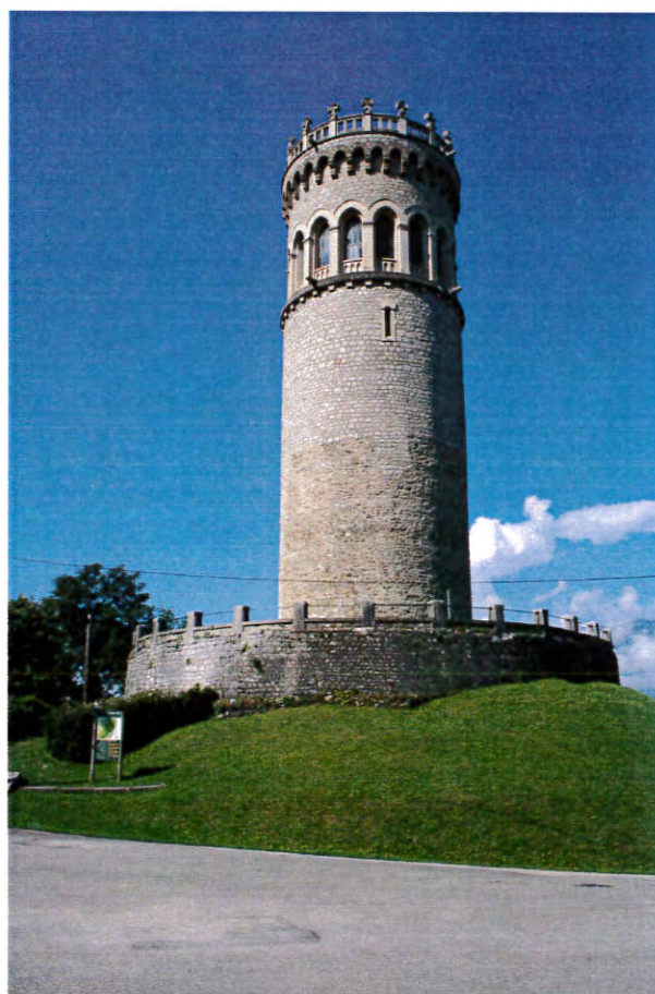
Tour d'Avalon – vue en élévation avec son mur de soutènement (déchaussement de maçonnerie en partie supérieure) - 2016
