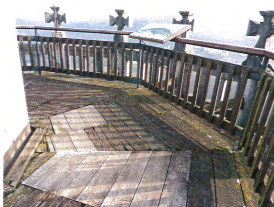
Terrasse de la tour – plancher bois et garde-corps dégradés, étanchéité à refaire - 2015
