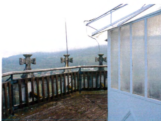
Unité départementale de l'Architecture et du Patrimoine de Terrasse de la tour – plancher bois dégradé Édicule à réviser et remettre en peinture - 2015
