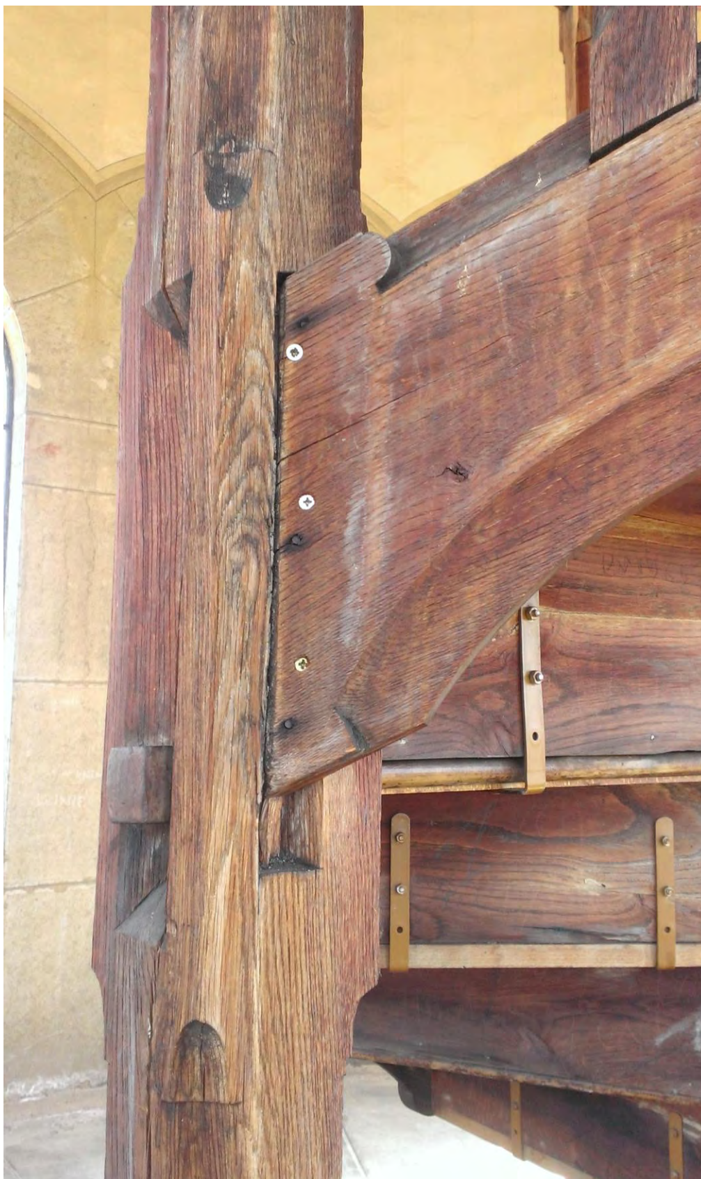
Ces équerres disgracieuses seront supprimée après remplacement des marches défectueuses.
