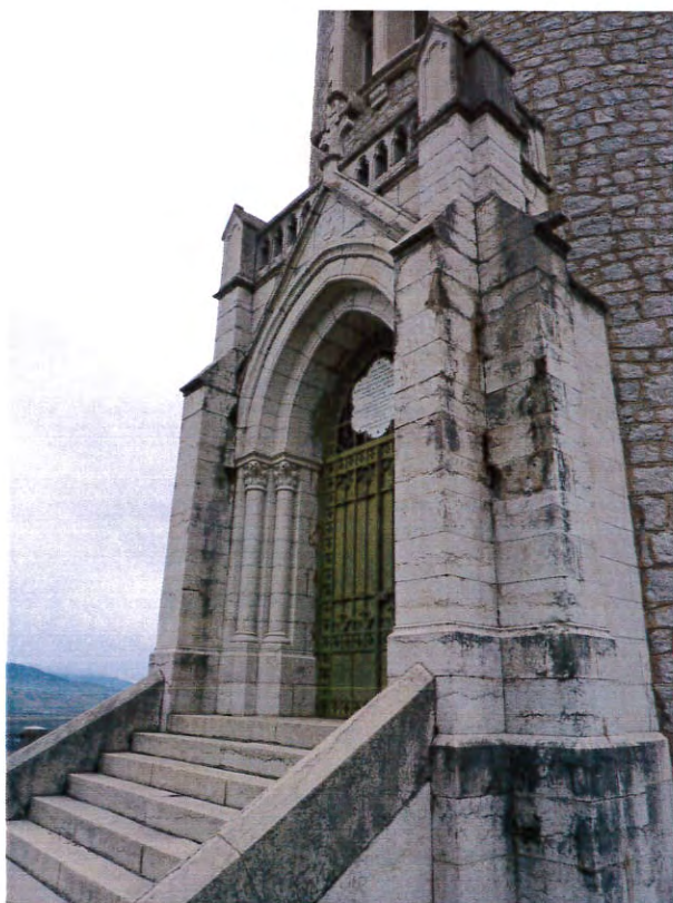
Porche d'entrée de la chapelle Traces importantes d'humidité – développement de mousses et d'algues noires - 2018
