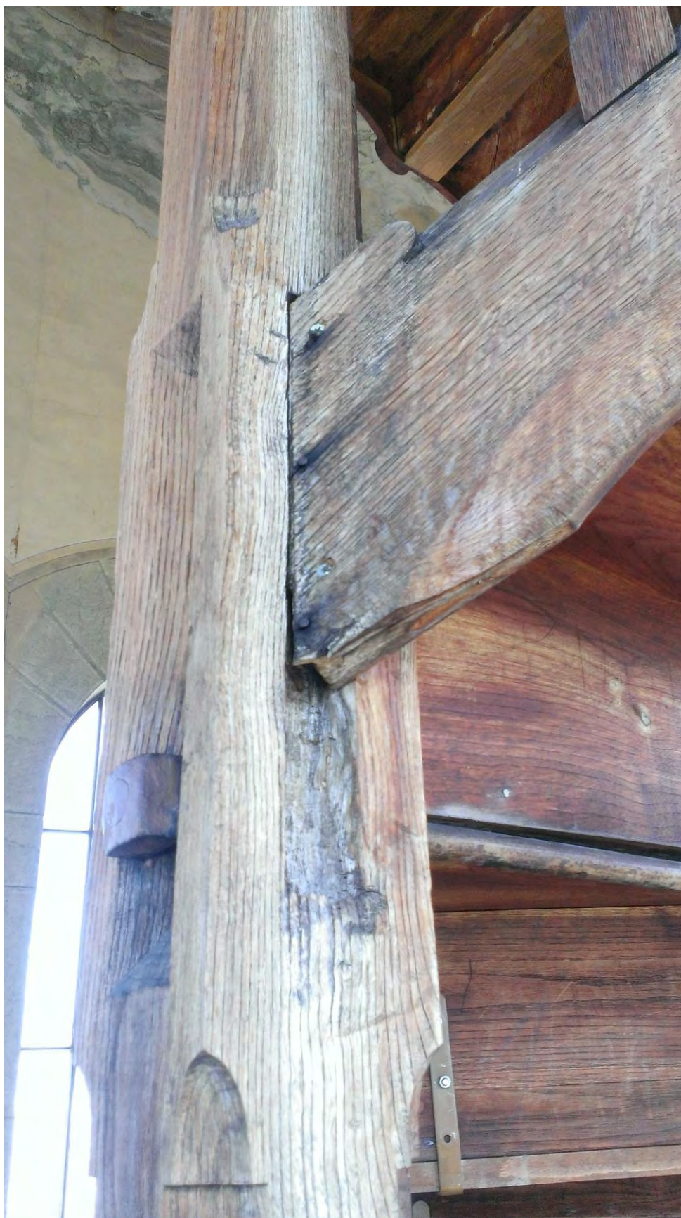
Assemblage limon-poteau fragilisé nécessitant le remplacement du limon
