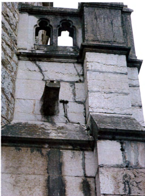
Porche d'entrée de la chapelle Traces d'infiltrations, développement de mousses, algues fissures, joints dégradés - 2018
