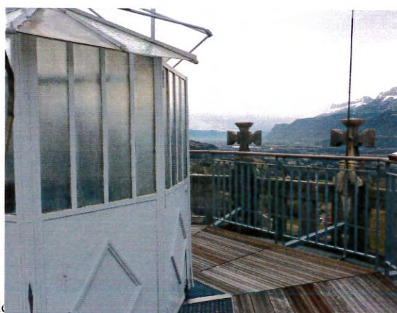
Mise en place d'un caillebotis et d'un nouveau platelage – l'édicule n'a pas été traité (non inclus) - 2018
