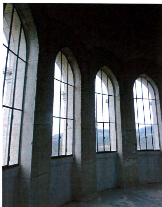
Nettoyage des allège, réfection de l'étanchéité des menuiseries métalliques et remise en peinture - 2018
