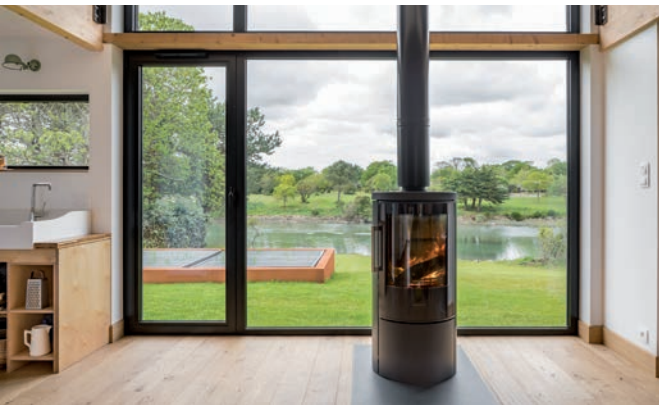
▲ Le poêle à bois, seul chauffage de la maison. L'espace de la trémie où passe le tuyau permet une circulation libre de l'air et de la chaleur.
