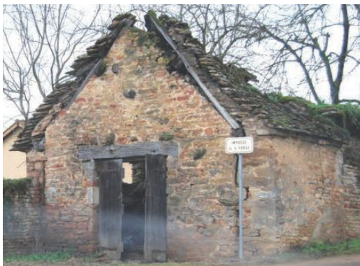
Lavoir de Givry ou des Rues. Ensemble hydraulique composé d'un puits couvert à battière, d'une auge ou bâchasse enterrée à fleur de terre et d'un lavoir couvert. Cliché C. Boulay, 2009.
