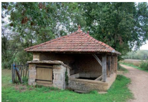
Lavoir de Givry ou des Rues. Ensemble hydraulique composé d'un puits couvert à battière, d'une auge ou bâchasse enterrée à fleur de terre et d'un lavoir couvert. Cliché C. Boulay, 2009.
