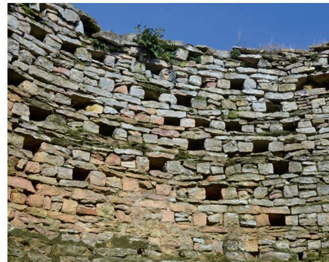
Colombier de Givry, trous de boulins. Cliché J-P Charbon, mars 2018. On peut distinguer 9 à 10 rangs de nichoirs ouverts ou comblés.
