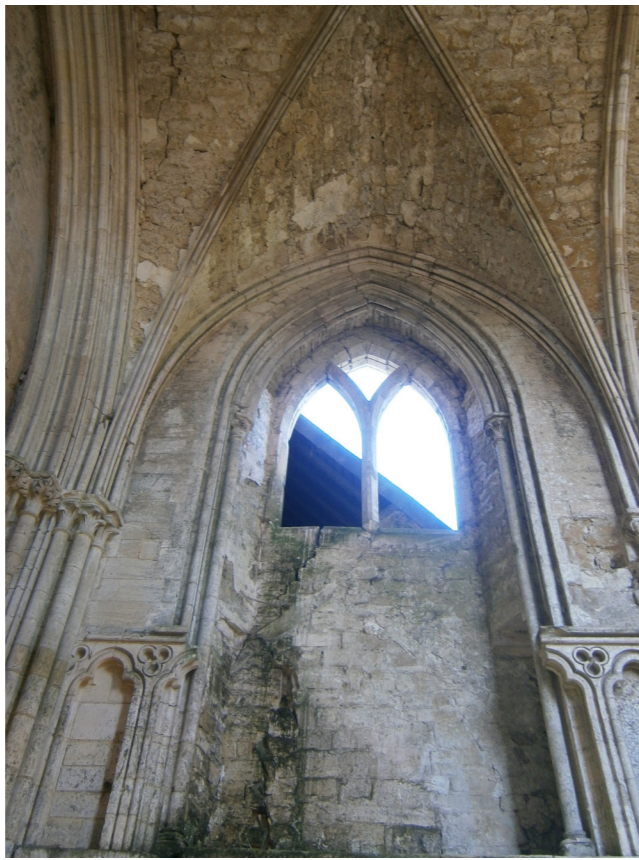
Vue B : Côté intérieur la fissure est également apparente, en partie traversante, la maçonnerie sous la baie étant assez peu épaisse, et se poursuit à la verticale jusqu'à une pierre d'appui de baie qui est brisée.
