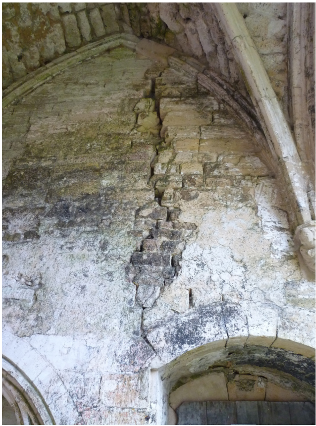
Vue A : La fissure qui apparaît côté bras de transept nord devra-t'être remaillée, plusieurs moellons ont été sectionnés. Il faudra recréer un harpage. (A rapprocher également de la fissure apparaissant en façade au dessus de la baie et ayant été remaillée lors de la dernière campagne de travaux.)
