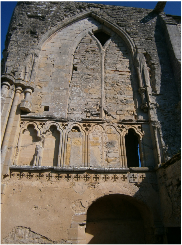
Vue D : On a dans cette ancienne grande baie qui ouvrait sur le transept sud un remplissage assez hétéroclite avec une baie inscrite à l'intérieur du formeret. La baie à deux lancettes et poinçon est semblable aux autres baies du chœur mais moins haute et basée sur des balustres en symétrique de celle de la coursière du triforium. Plusieurs fissures et désordres apparaissent.
