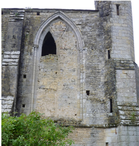
Remplissages de baies instables et désorganisés. On peut voir dans la maçonnerie le réemploi d'anciens claveaux et pierres de remplage qui feront l'objet d'un suivi archéologique lors de la dépose.
