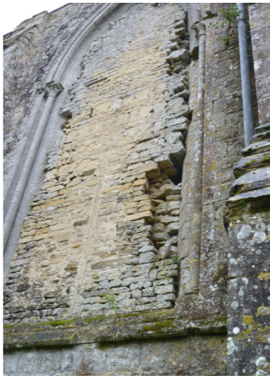
Remplissages de baies instables et désorganisés. On peut voir dans la maçonnerie le réemploi d'anciens claveaux et pierres de remplage qui feront l'objet d'un suivi archéologique lors de la dépose.
