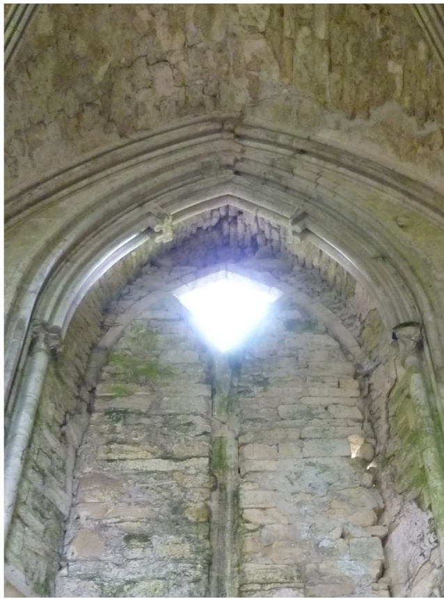
Vue C : Une fissure file en voûture. Les claveaux de la baie intérieure et du formeret ont également bougé, on observe un décalage que l'on retrouve en extérieur.
