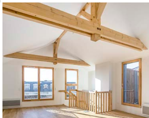
La charpente anime le dernier étage
