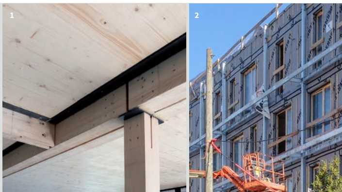
1_L'association du CLT et des profils HEA permet de diminuer l'épaisseur des planchers 2_Les balcons sont désolidarisés et composés d'une structure métallique et d'un platelage bois
