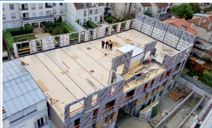
L'opération en cours de levage
