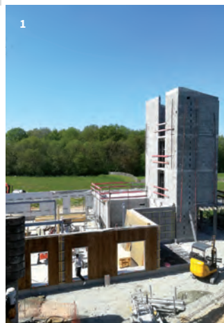
1_Partie maçonnée pour la cage d'ascenseur et les escaliers 2_Réception du chantier
