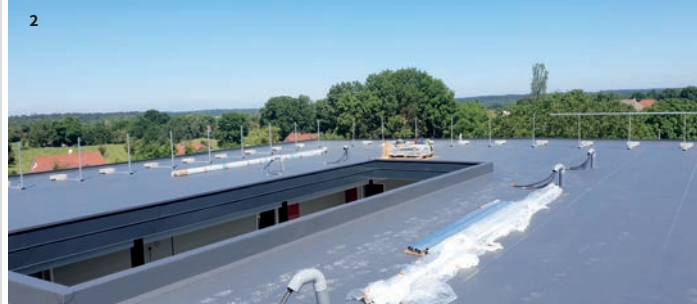
1_Le chauffage est réalisé par des câbles chauffants électriques. 2_Une membrane assure l'étanchéité de la toiture terrasse chaude.
