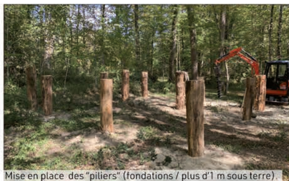
Mise en place des "piliers" (fondations / plus d'1 m sous terre).
