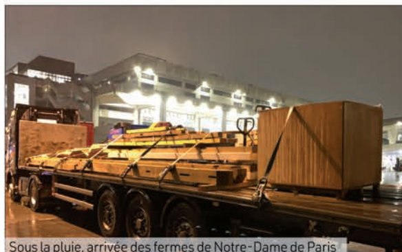
Sous la pluie, arrivée des fermes de Notre-Dame de Paris
