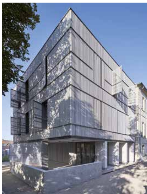
▲ Du pin d'Alep issu de la forêt des Alpilles pour le bardage, les brise-soleil et les volets.
