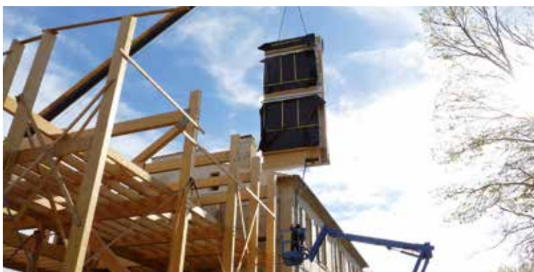
▲ Mise en place des caissons bois remplis de paille de blé comprimée, préfabriqués en atelier.
