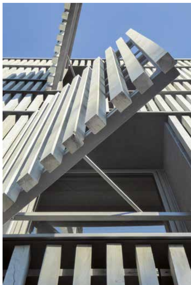
▲ Du pin d'Alep issu de la forêt des Alpilles pour le bardage, les brise-soleil et les volets.
