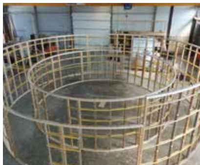
▲ L'ossature autoporteuse en Douglas de « Eden » : 11 m de diamètre, 4 m à son plus haut sommet.
