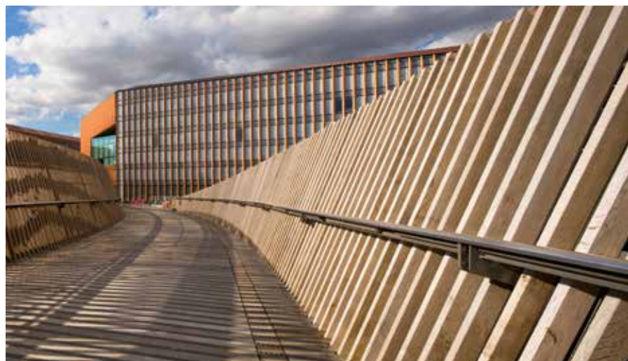
▲▲ Chêne français en platelage et en bardage à claire-voie
