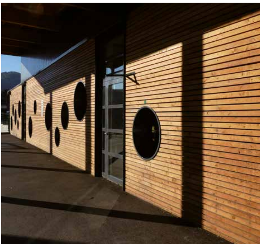
▲ Résineux local décliné en bardage posé à l'horizontale.
