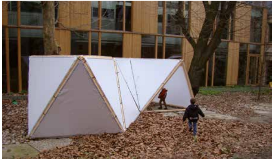
▲ Un travail sur des abris réalisés à partir d'éléments triangulaires en bois de 3 mètres sur 3.
