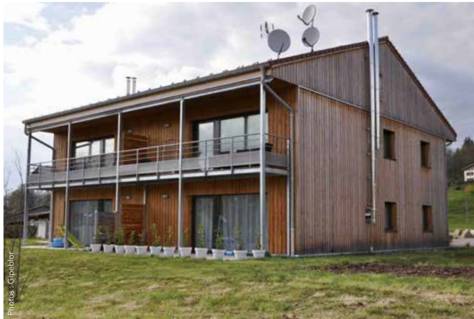
▲ Un concept constructif qui privilégie une architecture compacte et passive avec du bois local.
