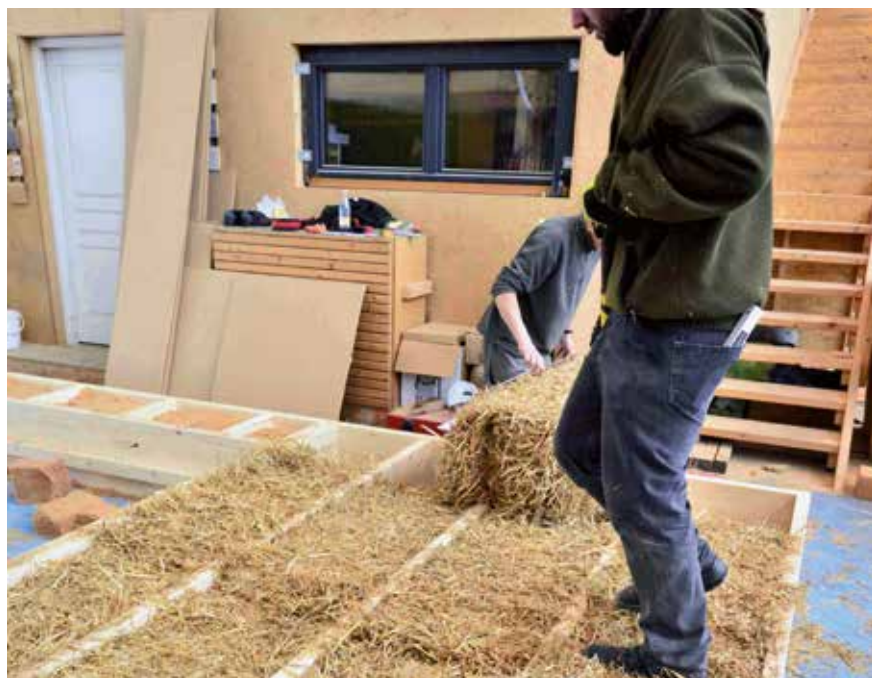
▲ Le projet met en œuvre une structure bois isolée avec de la paille.
