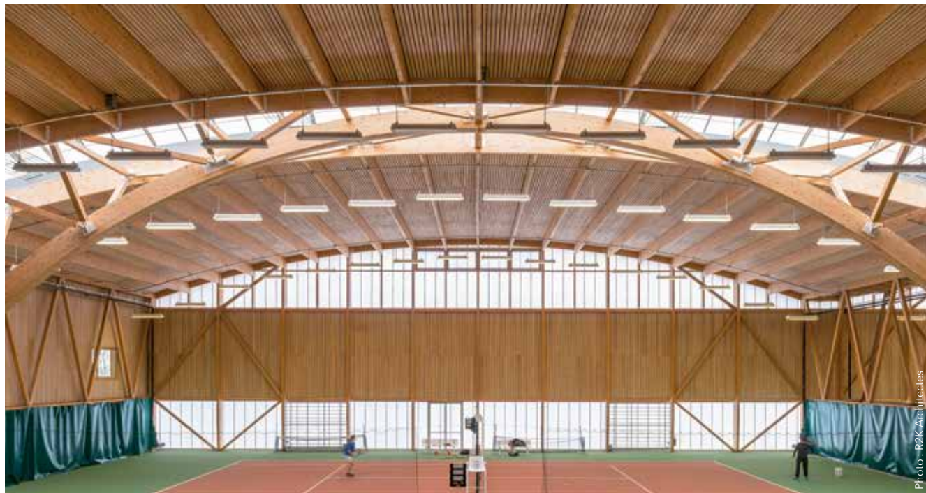
▲ Les nouveaux terrains de tennis de Grenoble (38), réalisés par le cabinet R2K Architectes, font la part belle au peuplier.
