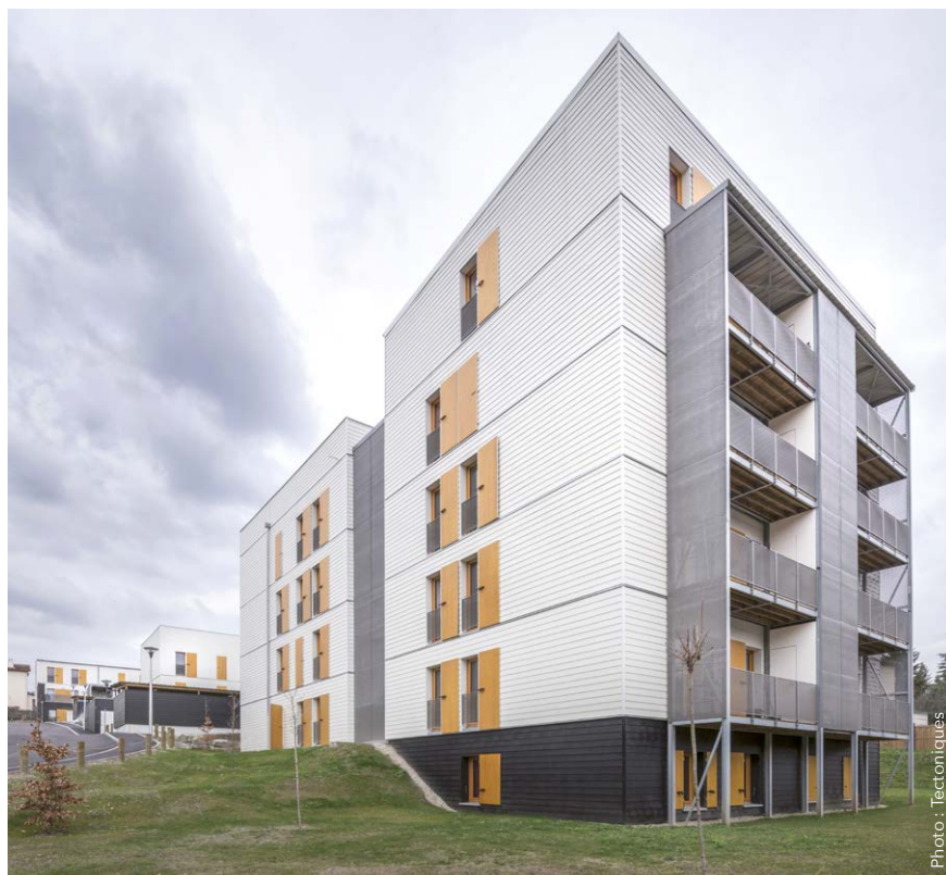
▲ Construction de 60 logements à Rive-de-Gier (42). Architecte : Tectoniques ; constructeur : Ossabois
