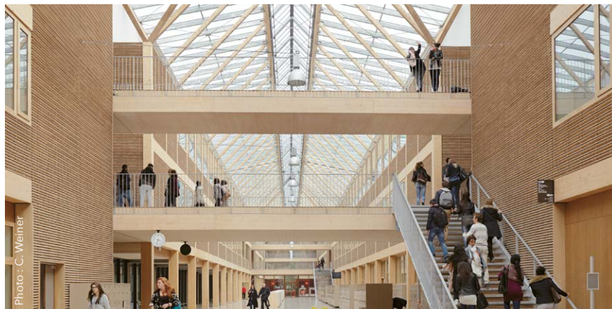
▲ Lycée Nelson-Mandela à Nantes (44), Premier Prix Bâtiments publics éducation et culture. Agence François Leclercq Architectes Urbanistes.
